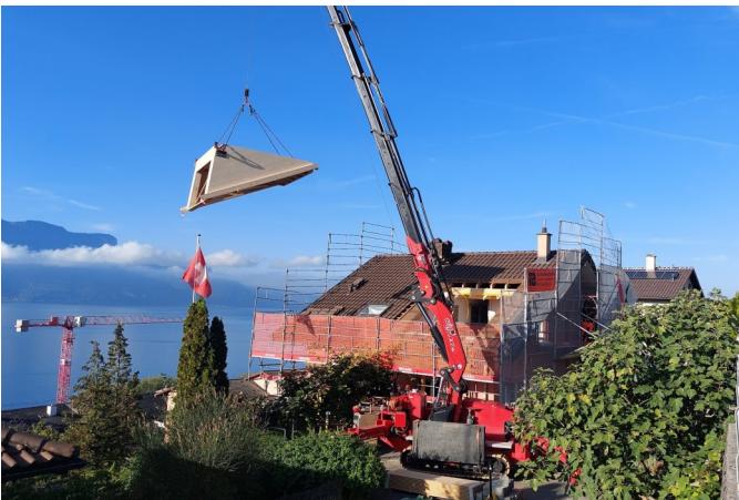
Pose d'une lucarne
