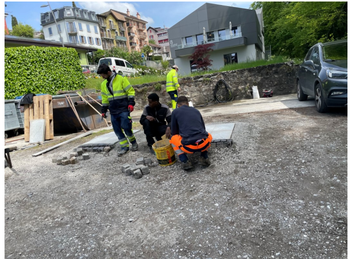
Travaux des apprentis sous la supervision des formateurs
