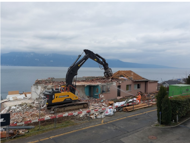
Démolition d'un immeuble
