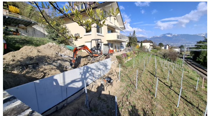
Police des constructions : construction d'une terrasse
