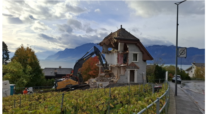
Police des constructions : démolition d'une maison
