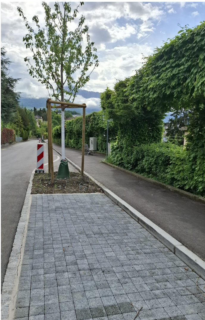
Réfection de la route des Cerisiers et pose de pavés filtrants
